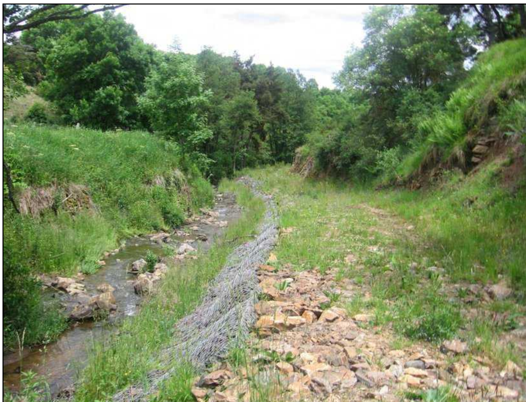
Ruisseau de Fraissine – protection d'un chemin contre l'érosion (source BRGM, prise de vue juin 2009)
