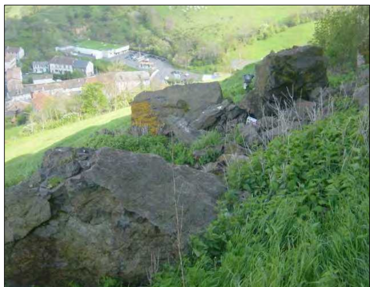
Chute de blocs en contrebas de la place J Brisson (source LRPC, prise de vue mai 2010)
